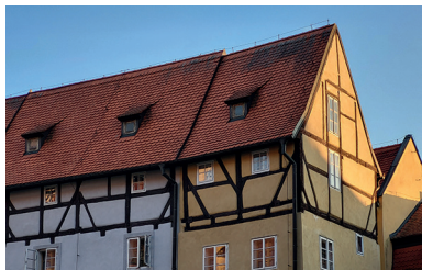
Obr. 27: Cheb (ČR), Špalíček-Kupecké domy z 13. storočia – hrázená konštrukcia posledného podlažia a strešného štítu z 15. storočia (Ľ. Suchý, 2023)
