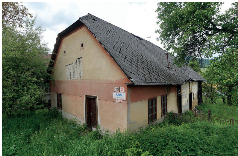
Obr. 01: Bardejov-Dlhá Lúka, Hlavná ul. 2109/52, JV nárožie čelnej a dvorovej strany domu (foto M. Volovár, 2025).
