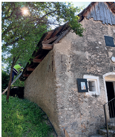
Obr. 02: Kontrola stavu strešnej krytiny, čistenie od machu a konárov na kamennej sýpke Vlkolínece, foto: J. Příbyl
