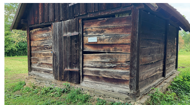
Obr. 22: Strážnice, Múzeum vesnice jihovýchodní Moravy (ČR), senník – rámová drážková konštrukcia, prvky zavetrenia stien sú z interiérovej strany (Ľ. Suchý, 2025)
