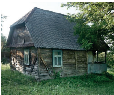
Obr. 20: Veľatyno, Čerešneva vul. 23 (UA), dom ľudový z pol. 20. st. – rámová drážková konštrukcia s doskovou/fošňovou výplňou krytou plášťom z hlinenej mazaniny na šikmom latovaní (M. Volovár, 2021)
