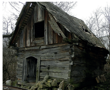
Obr. 06: Zrub sýpky zo štiepaných, fošňovitých trávov. Praha (2023)
