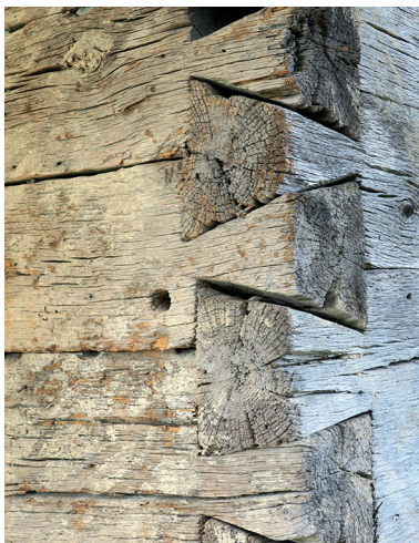
Obr. 15: Povârgina (R), drevený chrám z 2. pol. 18. st. – nárožie nosnej zrubovej konštrukcie bez pôvodného plášťa z lát a hlinenej mazanice, s klinovitým plátovaním na obojstrannú rybinu (Ľ. Suchý, 2025)
