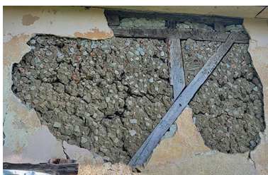
Obr. 32: Boliarov, Kúria Baltazára Egerera z roku 1863 – nosná hrázená dražková konštrukcia s dreveným výpletom a hlinenou mazanicou s úlomkami stavebnej keramiky, pôvodne pod vápennou omietkou (Ľ. Suchý, 2025)
