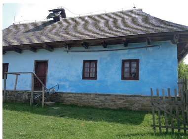
Obr. 06, 07, 08: Hospodárske usadlosti sa bielili tak, že do bieleho vápna sa pridávala modrá farba – svetlička, tzv. belavka. Pridávaním farby v rôznom pomere sa vytvorili variácie viacerých odtieňov modrej farby
