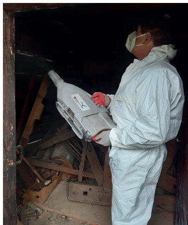
Obr. 04: Chemická sanácia konštrukcií exteriéru objektov v MLD Pribylina, foto: J. Příbyl
