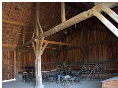
Obr. 06: Neusath-Freilandmuseum (D), stodola — nosná stĺpiková konštrukcia na kamenných pätkách, kombinovaná rámovou konštrukciou podporujúce sedlový krov (L. Suchý, 2014)
