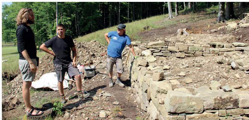
Obr. 05: Zdění suchých kamenných stěn, 2024 (foto Radek Bryol)
