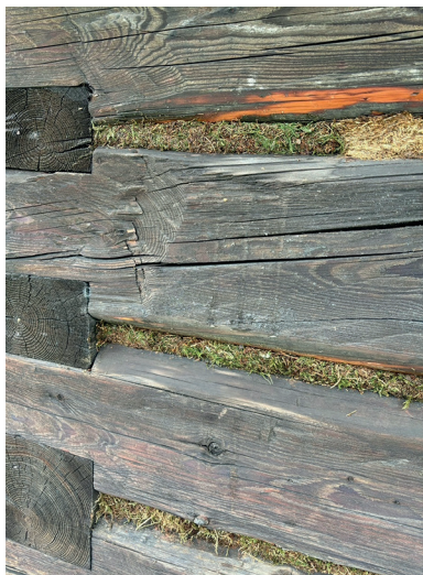
Obr. 12: Kontrast medzi novou a pôvodnou izoláciou
