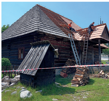
Obr. 16: Výmena degradovanej šindľovej krytiny kúria z Paludze v MLD Pribylina, foto: J. Příbyl
