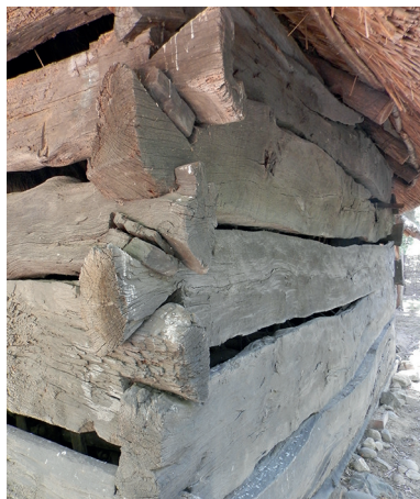
Obr. 08: Nárožie zrubu stodoly s výrazne hlbokými rybinovými väzbami. Palócke múzeum v Balážskych Ďarmotách (2024)
