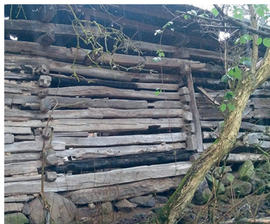
Obr. 05: Zrub z prikresaných prvkov s menšími prierezmi. Madačka (foto L. Jurčo, 2021)
