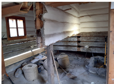
Obr. 10: Odstránenie interiérových zrubových konštrukcií po napadnutí drevomorkou, objekt z Liptovskej Sielnice v MLD Pribylina, foto: J. Příbyl
