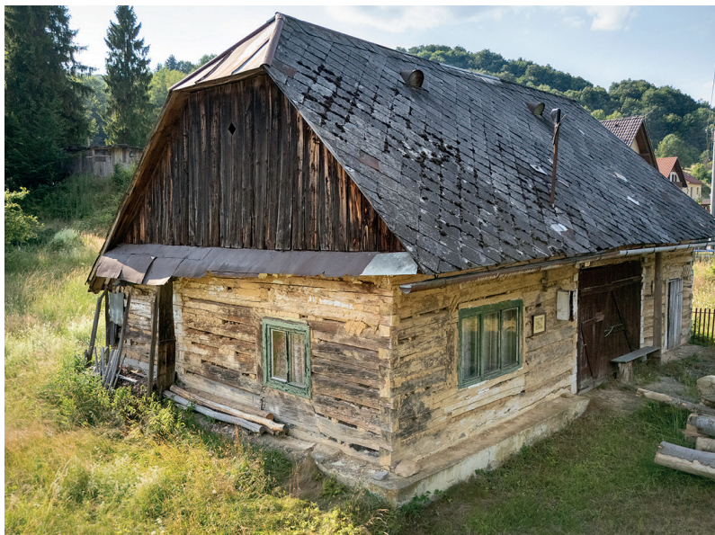
Obr. 04: Stebnická Huta, zrubový dom so sedlovou strecho na štíte podlomenicou (Vrabeľ 2025)
