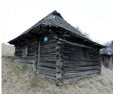
Obr. 02a: Juhovýchodný pohľad na Greškovu chyžku (Brada 2024)
