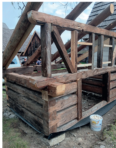
Obr. 23: Projekt realizácie doplnkovej hospodárskej architektúry k objektom – stavba obvodovej zrubovej konštrukcie chlieva s prípravou strešnej konštrukcie z materiálu využitého z iných pôvodných rozobraných objektov, MLD Pribylina, foto: J. Příbyl
