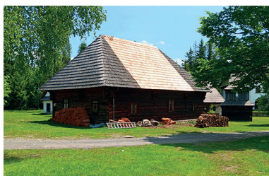
Obr. 17: Priebeh výmeny degradovanej šindľovej krytiny kúria z Paludze v MLD Pribylina, foto: J. Příbyl
