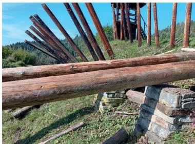
Obr. 15: Detail prípravy uloženia konštrukcie premostenia priekopy stredoveký hrádok Archeoskanzen Havránok, foto: J. Příbyl
