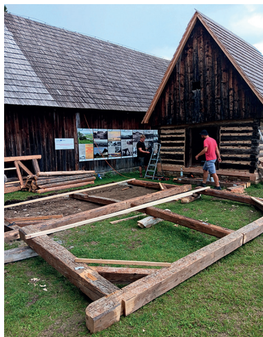
Obr. 19: Projekt realizácie doplnkovej hospodárskej architektúry k objektom – príprava konštrukcie kôlne z materiálu využitého z iných pôvodných rozobraných objektov, MLD Pribylina, foto: J. Příbyl
