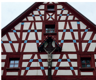
Obr. 01: Salajna-Dolní Ždanov (ČR), usadlosť čp. 9 z roku 1802 – poschodie budovy s hrázenou konštrukciou, 1802 (Ľ. Suchý, 2014)
