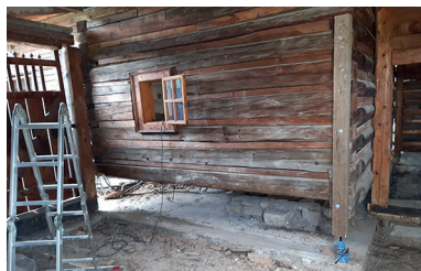
Obr. 08: Zdvihnutie a fixovanie zrubovej konštrukcie po odstránení degradovaného základového prvku po napadnutí drevo- morkou, objekt z Liptovskej Sielnice v MLD Pribylina, foto: J. Příbyl
