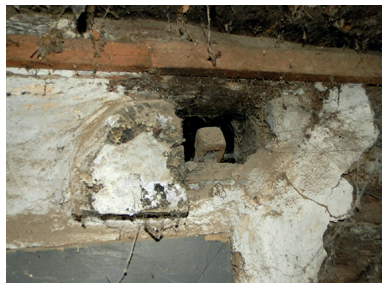
Obr. 16: Odvetrávací prieduch v priečke medzi izbou a pitvorom. Pohľad z pitvora (2023)
