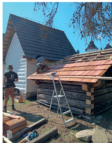
Obr. 24: Projekt realizácie doplnkovej hospodárskej architektúry k objektom – stavba chlieva, pokrývanie šindľovou krytinou, MLD Pribylina, foto: J. Příbyl
