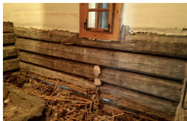
Obr. 07: Odstránenie vnútorných omietok na kópii objektu z Liptovskej Sielnice v MLD Pribylina, príprava pre sanáciu konštrukcií a na výmenu degradovaných prvkov po napadnutí drevomorkou, foto: J. Příbyl
