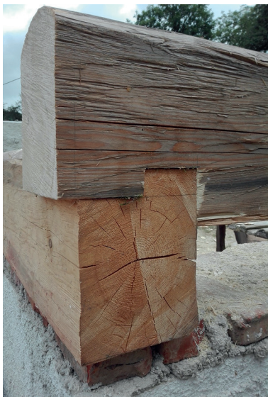
Obr. 14: Žitková (ČR), replika zrubovej konštrukcie – zámkový spoj v nároží dvoch spodných trámov (J. Štibravý – Tesané s. r. o., 2020)
