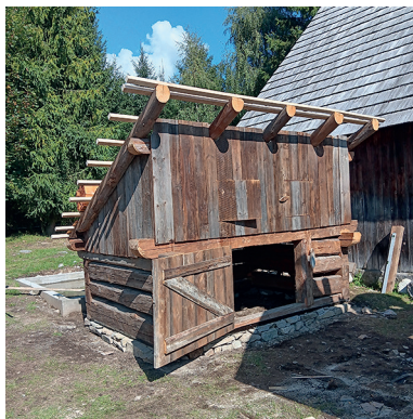
Obr. 22: Projekt realizácie doplnkovej hospodárskej architektúry k objektom – príprava prestrešenia stavby chlieva z materiálu využitého z iných pôvodných rozobraných objektov, MLD Pribylina, foto: J. Příbyl
