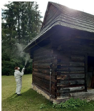
Obr. 03: Chemická sanácia konštrukcií exteriéru objektov v MLD Pribylina, foto: J. Příbyl
