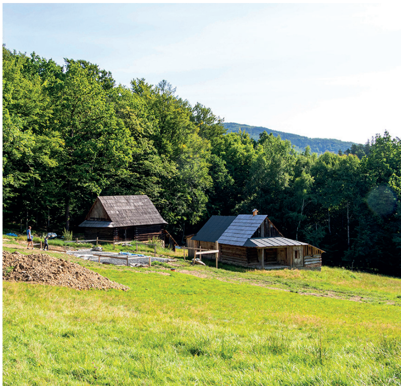
Obr. 03: Usedlost z Beskyd ve výstavbě, 2025 (foto Jan Kolář)
