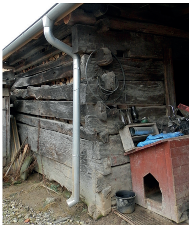
Obr. 07: Nárožie zrubu stodoly s použitím rôznych typov väzieb. Uhorské (2024)
