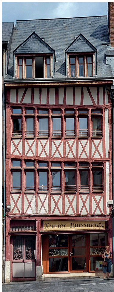
Obr. 26: Rouen, Rue aux Ours 42, Horná Normandia (F), meštiansky dom (16. st. ?) — poschodová hrázená konštrukcia uličného priečelia (Ľ. Suchý, 2023)
