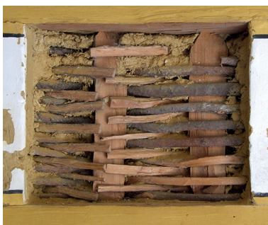
Obr. 31: Neusath-Freilandmuseum (D) – príklad vypletanej hrázenej konštrukcie s hlinenou mazanicou (Ľ. Suchý, 2014)
