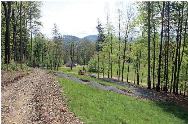
Obr. 02: Budování komunikační sítě v areálu, 2025 (foto Jan Kolář)
