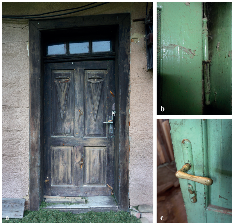
Obr. 06: Mokroluh (okr. Bardejov), č. 76, ukážky dverí a ich kovaní: a — dvere do siene; b — záves dverí zo siene do výmenku; c — kľučka a štítok dverí zo siene do izby (foto M. Volovár, 2025).
