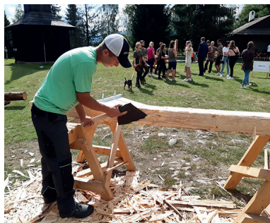
Obr. 26: Komunitná spolupráca so Strednou odbornou školou lesníckou a drevárskou Jozefa Dekreta Matejovie v Liptovskom Hrádku - študenti odboru zrubové stavby, kresanie konštrukčného prvku pre stavbu studne, MLD Pribylina, foto: J. Pribyl
