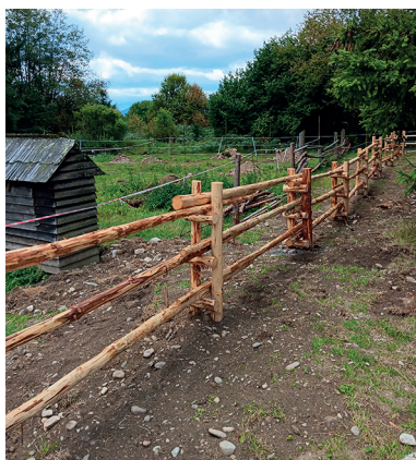
Obr. 18: Rekonštrukcia ohrád pre hospodárske zvieratá v MLD Pribylina, foto: J. Příbyl
