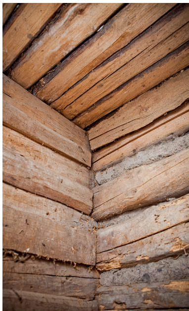
Obr. 01: Vypĺňanie štrbín maltovou zmesou v objekte Lašútovskej maštale v obci Divina, okr. Žilina
