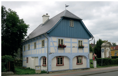
Obr. 30: Hrádek nad Nisou (ČR), Dom Koník z roku 1812 – kombinovaná zrubová konštrukcia s podstávkou na prízemí a zrubová na poschodí po obnove (Ľ. Suchý, 2019)
