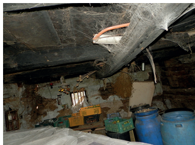
Obr. 15: Strop s prievlakom v izbe (2023)
