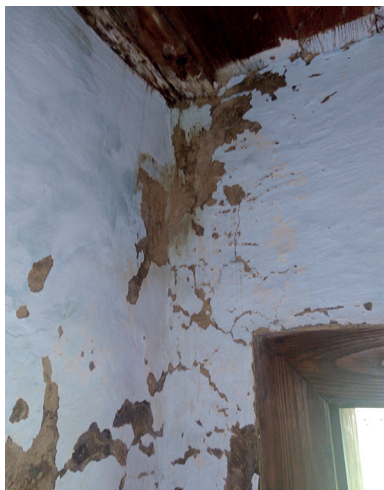
Obr. 01: Najstaršie zrubové stavby omaštené hlinou a pokryté slamou vplyvom počasia a nestálosti použitého prírodného materiálu strácali na svojom pôvabe.
