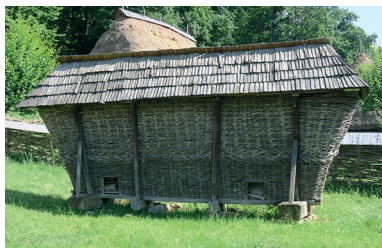
Obr. 07: Sibiu-národopisné múzeum ASTRA (R), sušiareň kukurice – stĺpiková konštrukcia na drevených pätkách/trá- moch s výpletom/košom (Ľ. Suchý, 2025)
