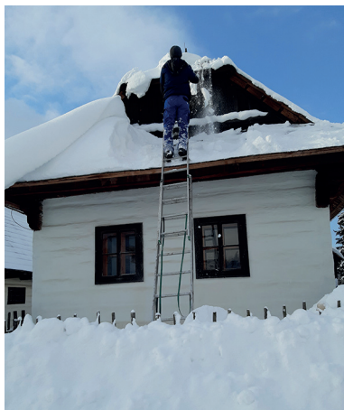
Obr. 01: Kontrola zafazenia krovných konštrukcií v MLD Pribylina — zhadzovanie snehu, foto: J. Příbyl
