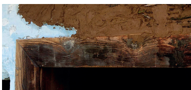
Obr. 03: Pôvodná hlinená omasta na zrubu tvorila až trojcentimetrovú vrstvu, bolo potrebné hmotu poriadne vymiešať a v rovnačkej vrstve naniesť.
