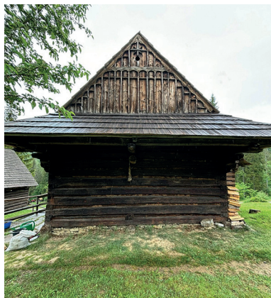
Obr. 10: Fasáda zrubového obytného domu „Do Potoka“ pred obnovou umšieváním
