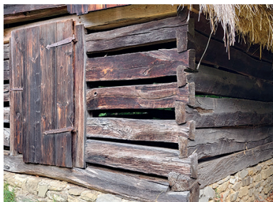
Obr. 16: Strážnice, Múzeum vesnice jiho- východní Moravy (ČR), senník – zrubová/ fošňová konštrukcia, nárožie s malým pre- sahom koncov plátované na obojstrannú rybinu (L. Suchý, 2025)
