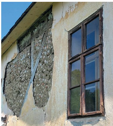
Obr. 35: Boliarov, Kúria Baltazára Egerera z roku 1863 — pod omietkou nosná drevená hrázdenná konštrukcia steny (Ľ. Suchý, 2025)
