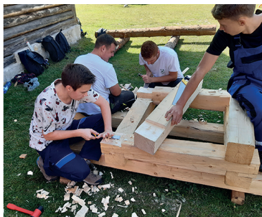
Obr. 25: Komunitná spolupráca so Strednou odbornou školou lesníckou a drevárskou Jozefa Dekreta Matejovie v Liptovskom Hrádku - študenti odboru zrubové stavby, spájanie konštrukcie studne pôvodnými konštrukčnými spojmi, MLD Pribylina, foto: J. Pribyl
