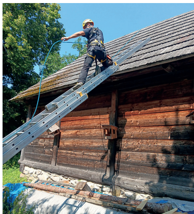
Obr. 05: Lokálne opravy šindľovej krytiny – Inšpekčný tím Pro Monumenta na humne Vlkolíne, foto: J. Příbyl
