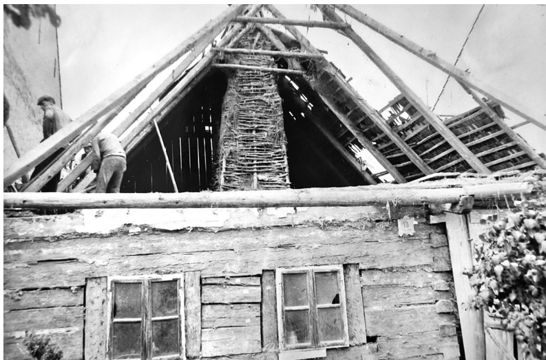
Obr. 04: Dom Jána Pangráca počas demontáže s obnaženou konštrukciou vypletaného komína
