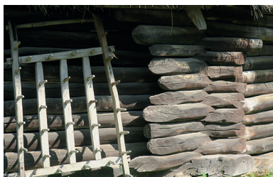
Obr. 13: Sibiu-národopisné múzeum ASTRA (R), polygonálna stodola – zrubová konštrukcia so skosenými nárožiami a presahmi obojstranne plátovaných koncov trámov/guľatiny (Ľ. Suchý, 2025)
