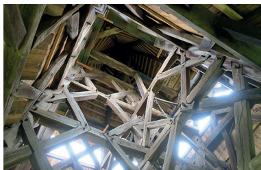
Obr. 23: Malé Ozorovce, drevená zvonica z roku 1619 — dubová rámová konštrukcia s množstvom diagonálne a horizontálne stužujúcich prvkov zavetrenia (Ľ. Suchý, 2022)
