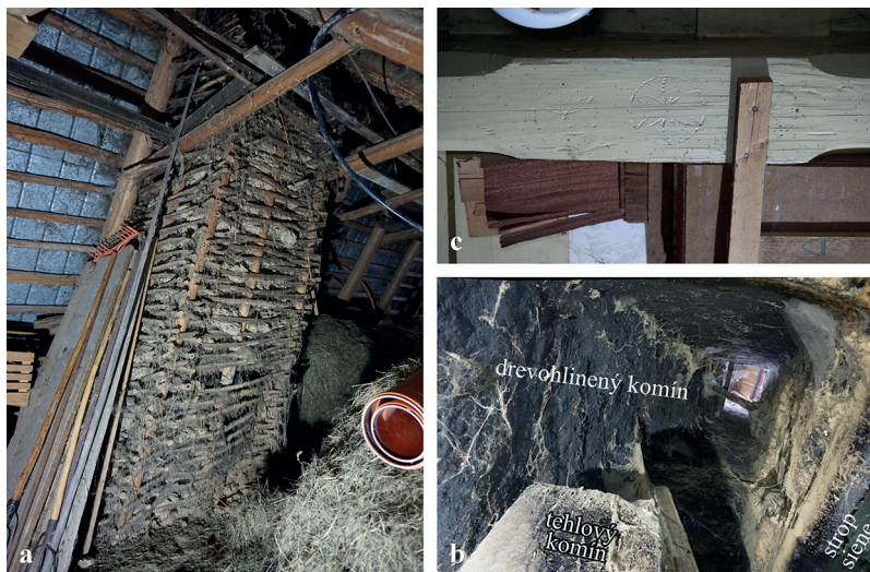
Obr. 07: Mokroluh (okr. Bardejov), č. 76: a, b – exteriér a interiér drevohlinitého komína na povale; c – symboly na stropnom tráme v izbe (foto M. Volovár, 2025).
