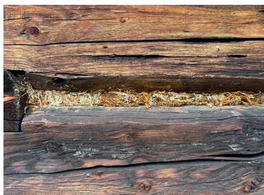
Obr. 13: Na objekt bývalého riečnického richtára Adama Poništa bol na niektorých miestach použitý aj ploník obyčajný ( Polytrichum commune ), avšak jeho húževnatosť a drôtovitosť sťažovali umšievanie
