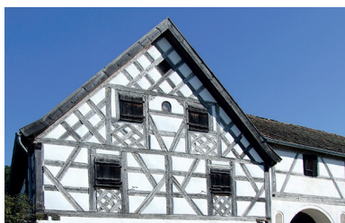
Obr. 28: Neusath-Freilandmuseum (D), Dom a hospodárska časť – hrázená konštrukcia s bohatým dekorom trámovej výbavy poschodí a strešného štítu, dole medzi oknami tzv. zostava muža (Ľ. Suchý, 2014)
