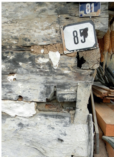
Obr. 13: Detail zrubovej konštrukcie so stopami po manipulácii pri ťažbe (2023)
