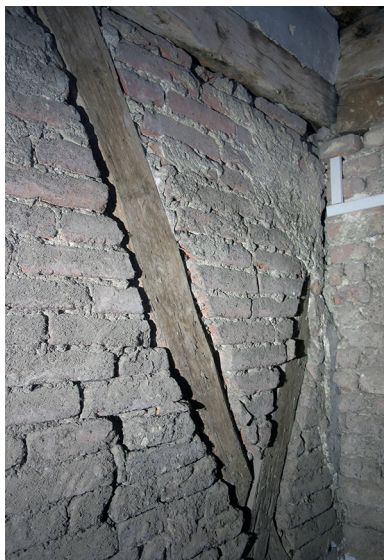
Obr. 33: Bučovice (ČR), Zámok — hrázdenná konštrukcia s tehlovou výplňou v podstreší zo 17./18. st. (Ľ. Suchý, 2025)
