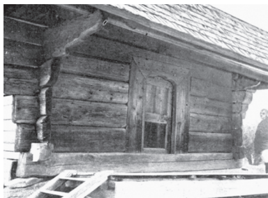
Obr. 12: Nová Sedlica, drevený Chrám archanjela Michala z roku 1794 – zrubová konštrukcia babinca s presahom plátovaných koncov nároží (zdroj: VYDRA, J.: Lidové stavitelství na Slovensku, vyd. Jan Štenc, Praha 1925, s. 135)
