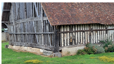
Obr. 34: Aclou, Horná Normandia (F), stodola z roku 1491 — dubová hrázdenná konštrukcia, pôvodne s kamennou výplňou (Ľ. Suchý, 2023)
