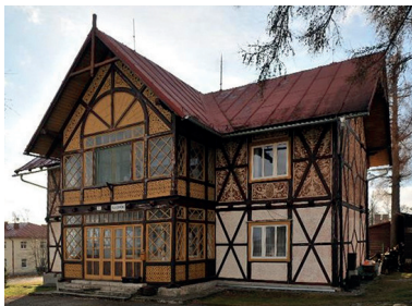
Obr. 37: Vysoké Tatry-Dolný Smokovec, Vila Kalinčiak z roku 1884 (G. Majunke) — priznaná nosná hrázdenná konštrukcia s tehlovou omietanou výplňou (Archív KPÚ Prešov, 2010)
