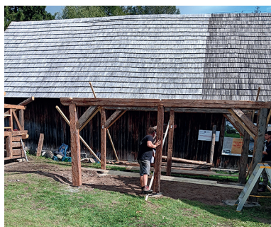
Obr. 20: Projekt realizácie doplnkovej hospodárskej architektúry k objektom – stavba zvislých konštrukcií kôlne z materiálu využitého z iných pôvodných rozobraných objektov, MLD Pribylina, foto: J. Příbyl
