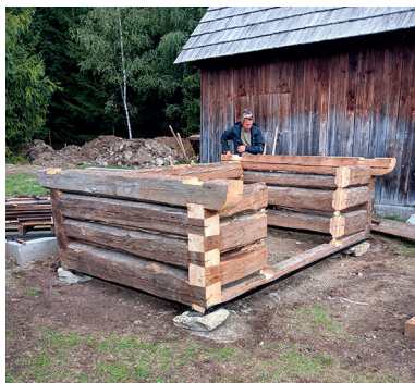
Obr. 21: Projekt realizácie doplnkovej hospodárskej architektúry k objektom – stavba obvodovej zrubovej konštrukcie chlieva z materiálu využitého z iných pôvodných rozobraných objektov, MLD Pribylina, foto: J. Příbyl
