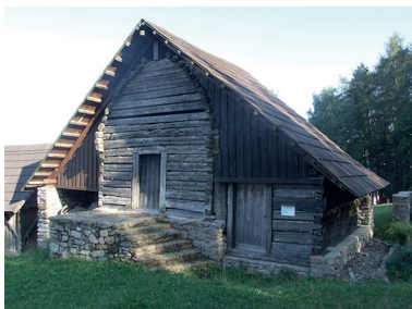
Obr. 18: Chanovice, skanzen (ČR), sýpka (18./19. st.) – zrubová konštrukcia stien a valenej lomenej klenby (L. Suchý, 2009)
