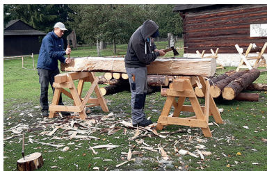
Obr. 11: Príprava konštrukčného prvku na výmenu pôvodnou technológiou, pre objekt z Liptovskej Sielnice v MLD Pribylina, foto: J. Příbyl
